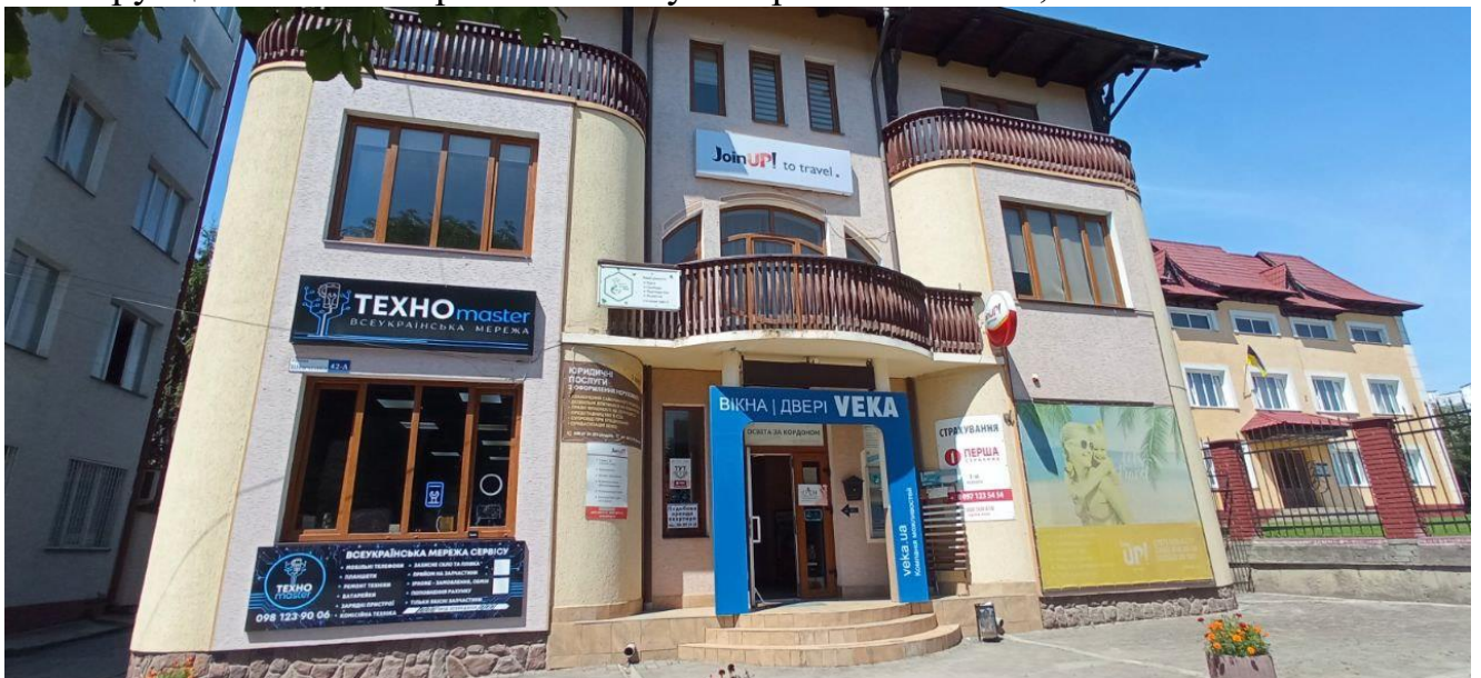
Конструкції зовнішньої реклами по вул. Тараса Шевченка, 42-А
